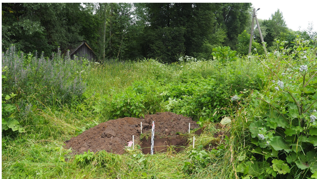
Рис. 38. Калужская область, Мещовский район. 2023 г. Археологическое обследование по объекту: «Уличные газопроводы дер. Торхово». Вид на раскопанный шурф 4 с юга.
