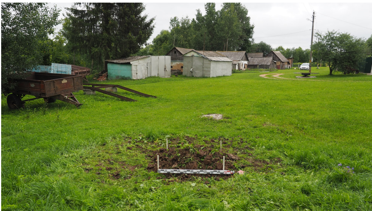
Рис. 36. Калужская область, Мещовский район. 2023 г. Археологическое обследование по объекту: «Уличные газопроводы дер. Торхово». Шурф 3 после засыпки. Вид с юга.
